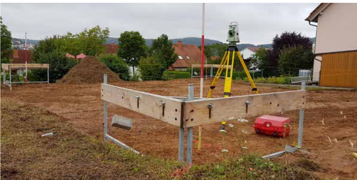
Zu den Aufgaben eines Vermessers gehört das Abstecken von Bauwerken.
